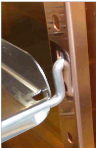
Figura 14-5. Instalação da estante de metal perfurada
