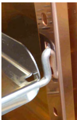
图 14-5. 金属打孔搁板安装
