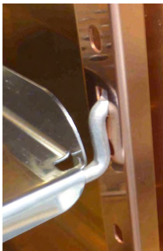
Рисунок: Установка перфорированной полки
