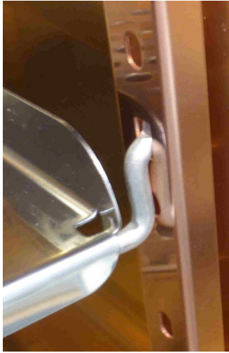
图： 打孔搁板安装
